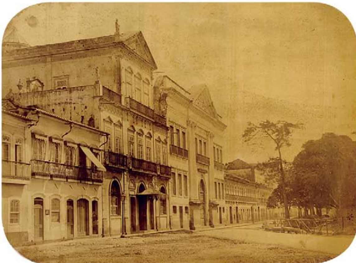
Neste registro fotográfico de 1834, nas janelas das casas e dos estabelecimentos comerciais da então capital federal, Rio de Janeiro, já havia sido acrescentado o vidro, que passou a dividir espaço com as folhas de madeira.
