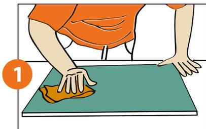
Verifique se a superfície onde será feita a colagem está limpa e nivelada. Limpe o lado pintado do espelho com um pano macio umedecido em álcool. Passe um pano seco para retirar o excesso.
