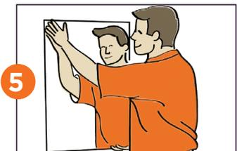
a) Não movimente mais a peça após a fixação na parede. A cura total será feita após algumas horas.
